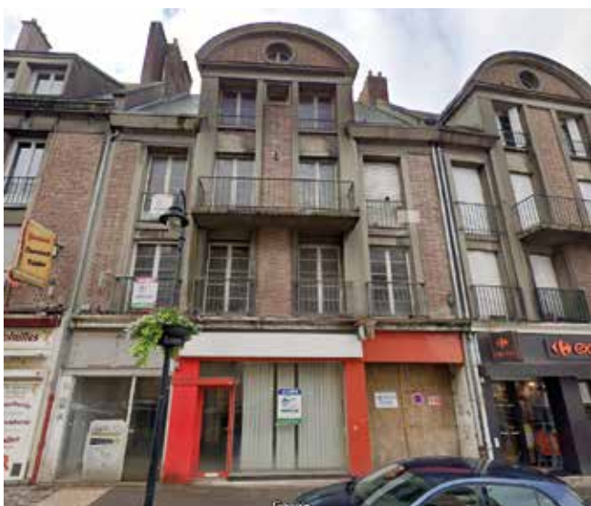
L'immeuble situé 6 chaussée du Bois, à côté de Carrefour express, à l'abandon depuis des années, fait l'objet d'une réhabilitation complète dans le cadre de l'OPAH : création d'une cellule commerciale et de 4 logements aux étages.
