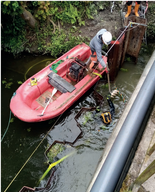
Travaux réalisés à la porte du Doigt, pour sécuriser l'ouvrage existant avant de pouvoir le remplacer cet hiver.
